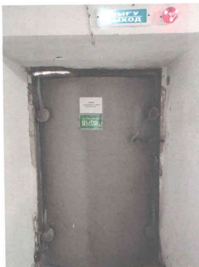
Запасной выход подвал
